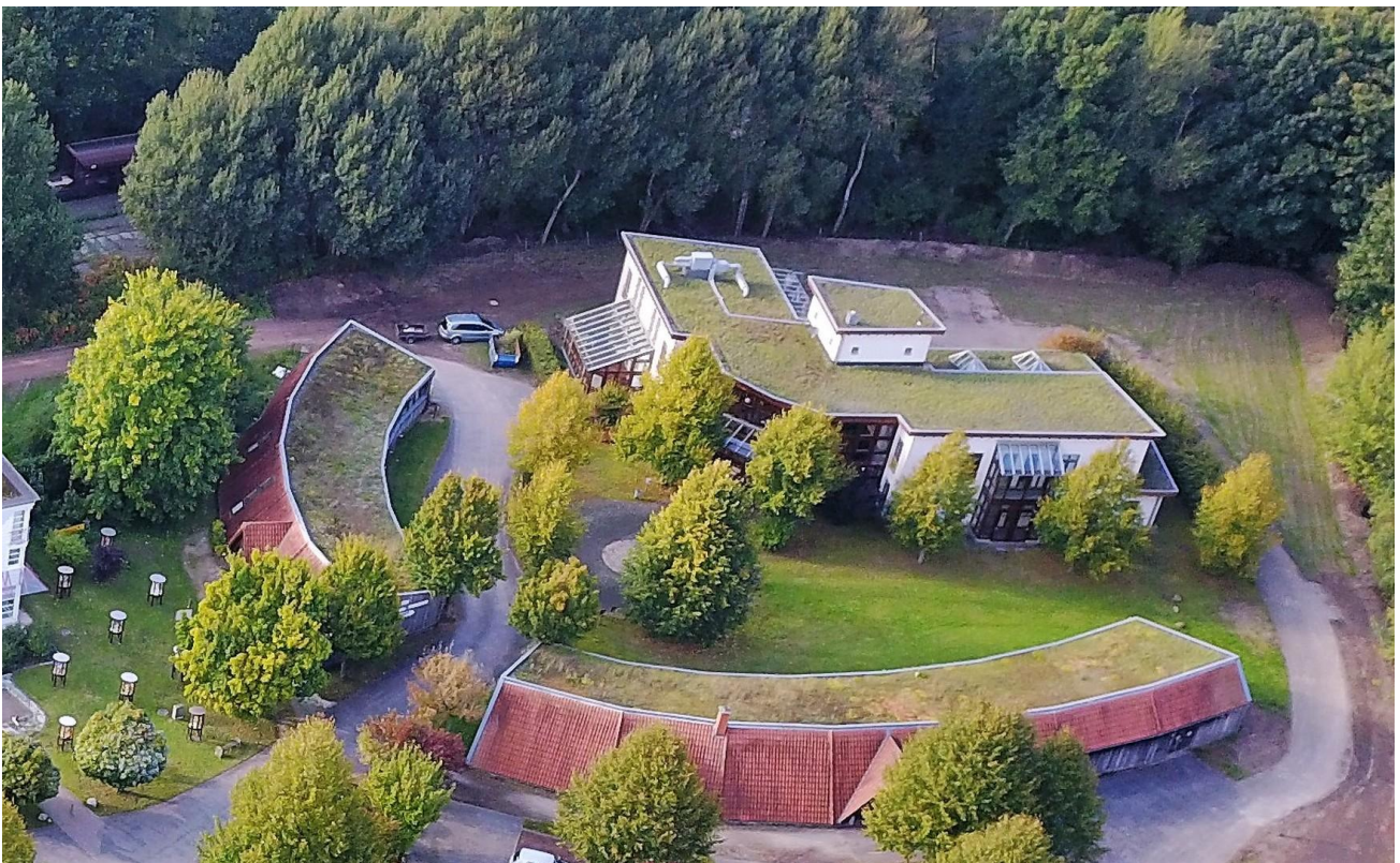
Haus "H" und Hufeisengebäude
