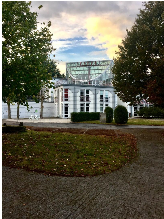
Zentralgebäude mit Bürotrakt
