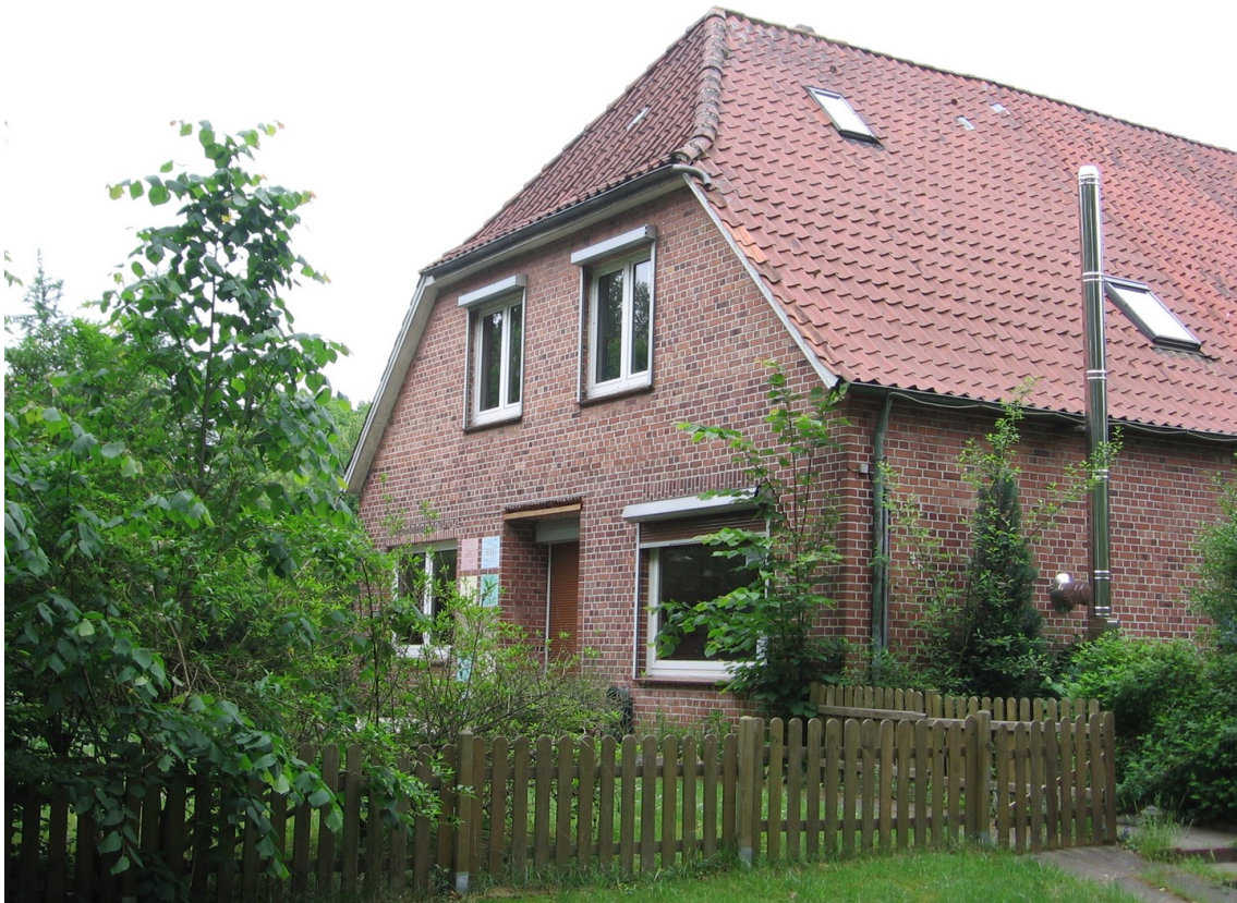
Eingang Ostseite + Südseite
