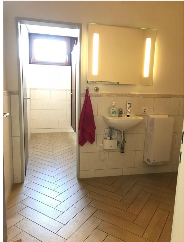
Ein Blick in die WC-Anlage
