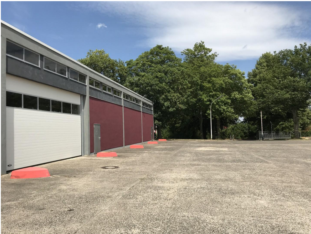
Lagerhalle ca. 600 qm
