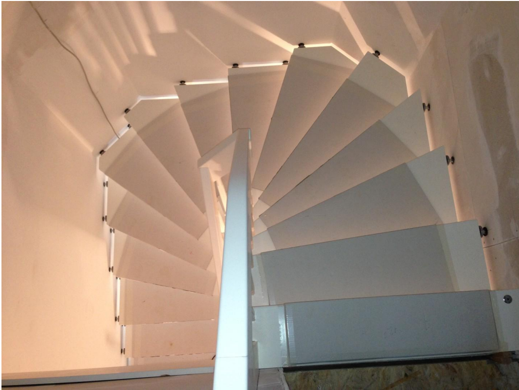
Treppe im DG/SPB
