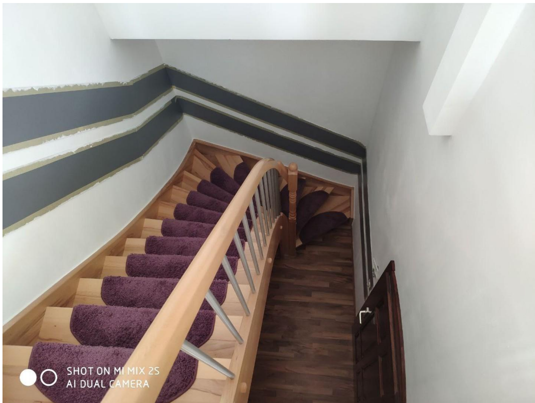
Treppenaufgang mit Stoßschutz
