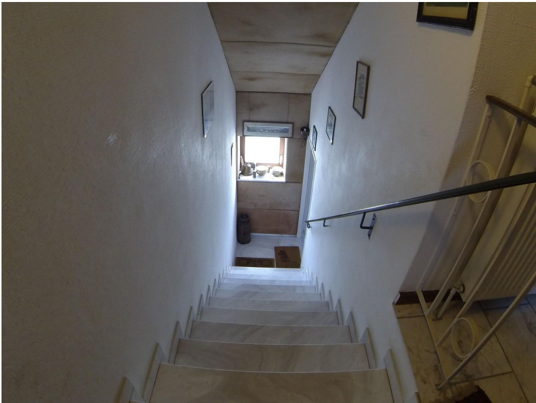
Treppe EG in Realität breiter
