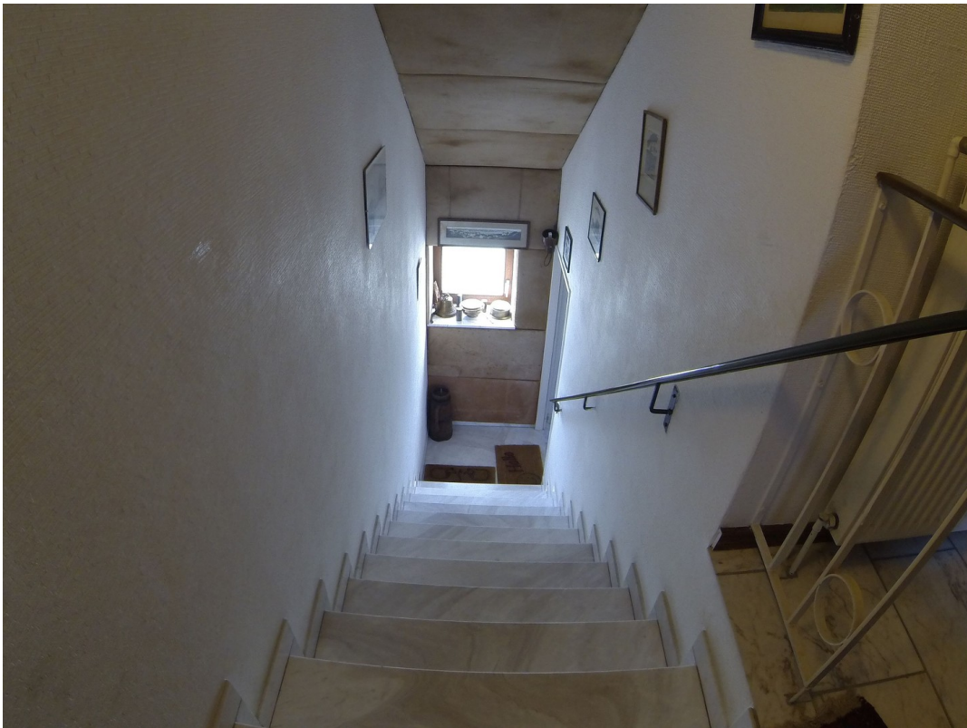
Treppe EG in Realität breiter
