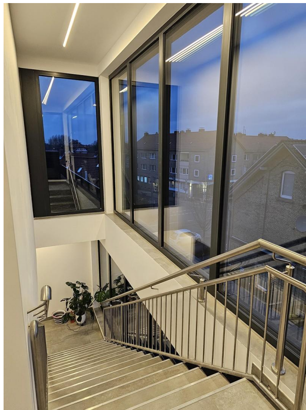
Treppenhaus im 3 OG
