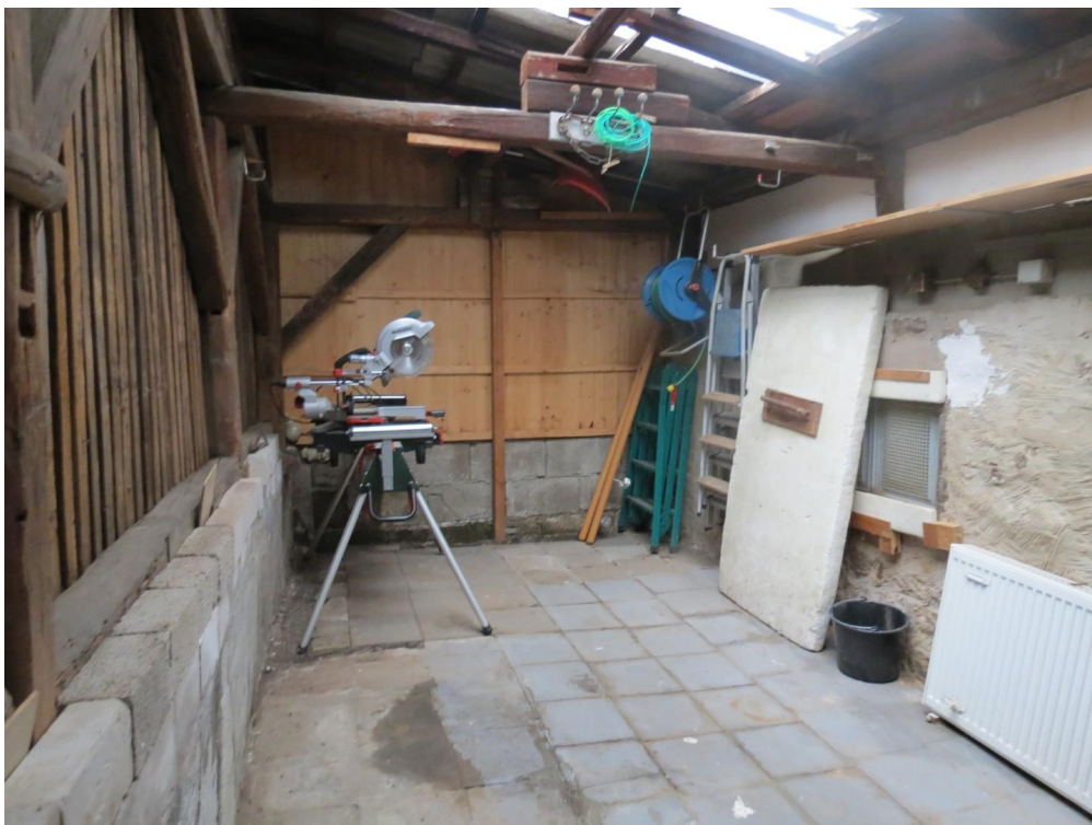
Anbau neben der Werkstatt
