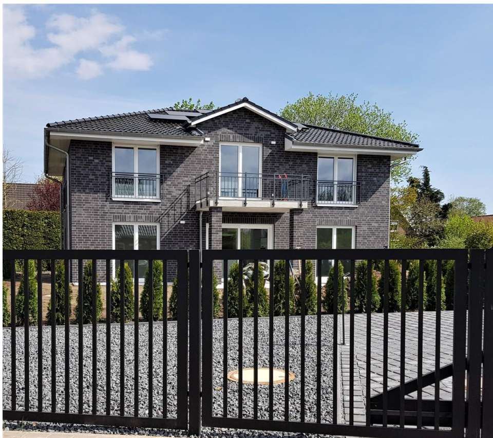
Haus elektrischer Toranlage
