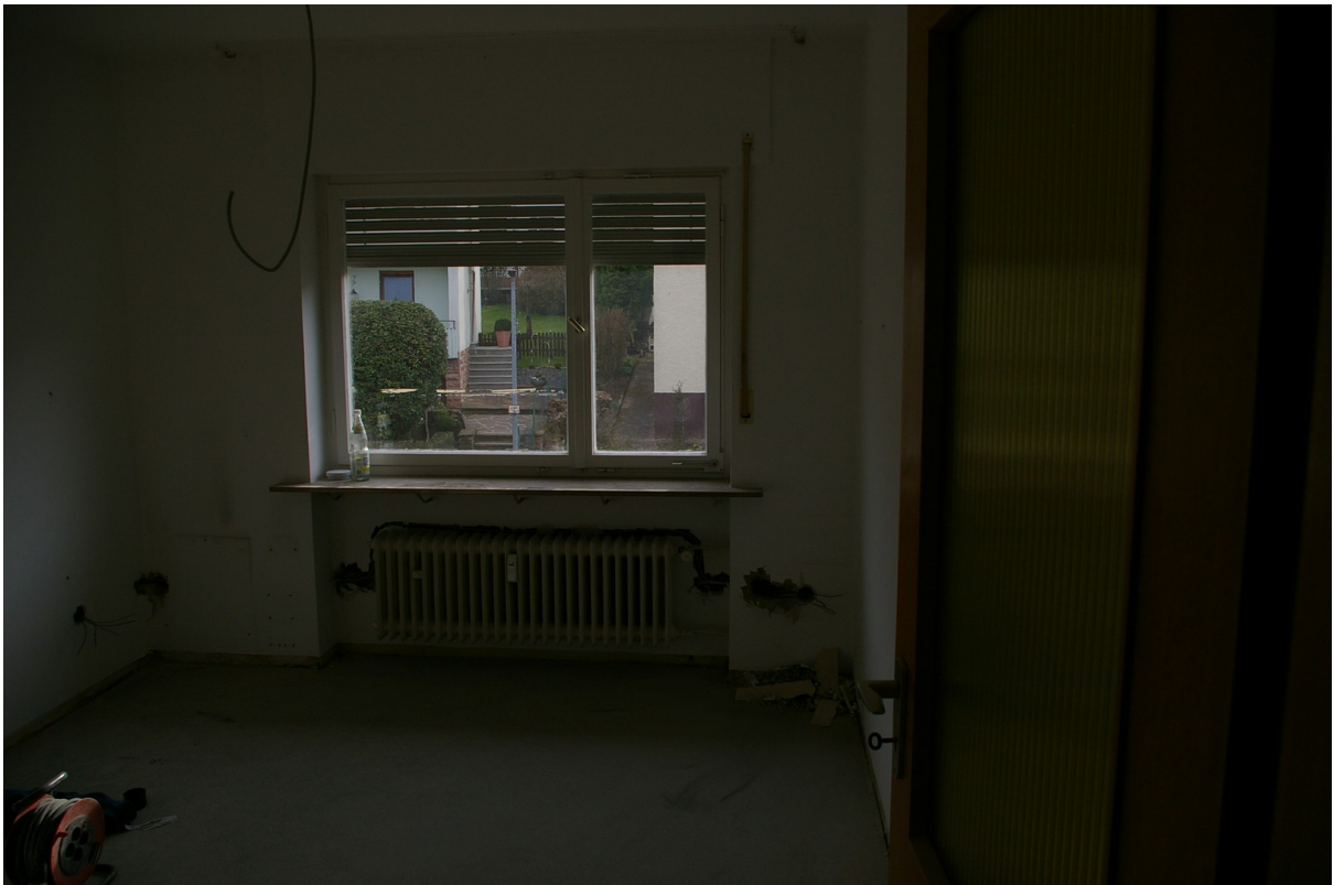
Blick in ein Kinderzimmer
