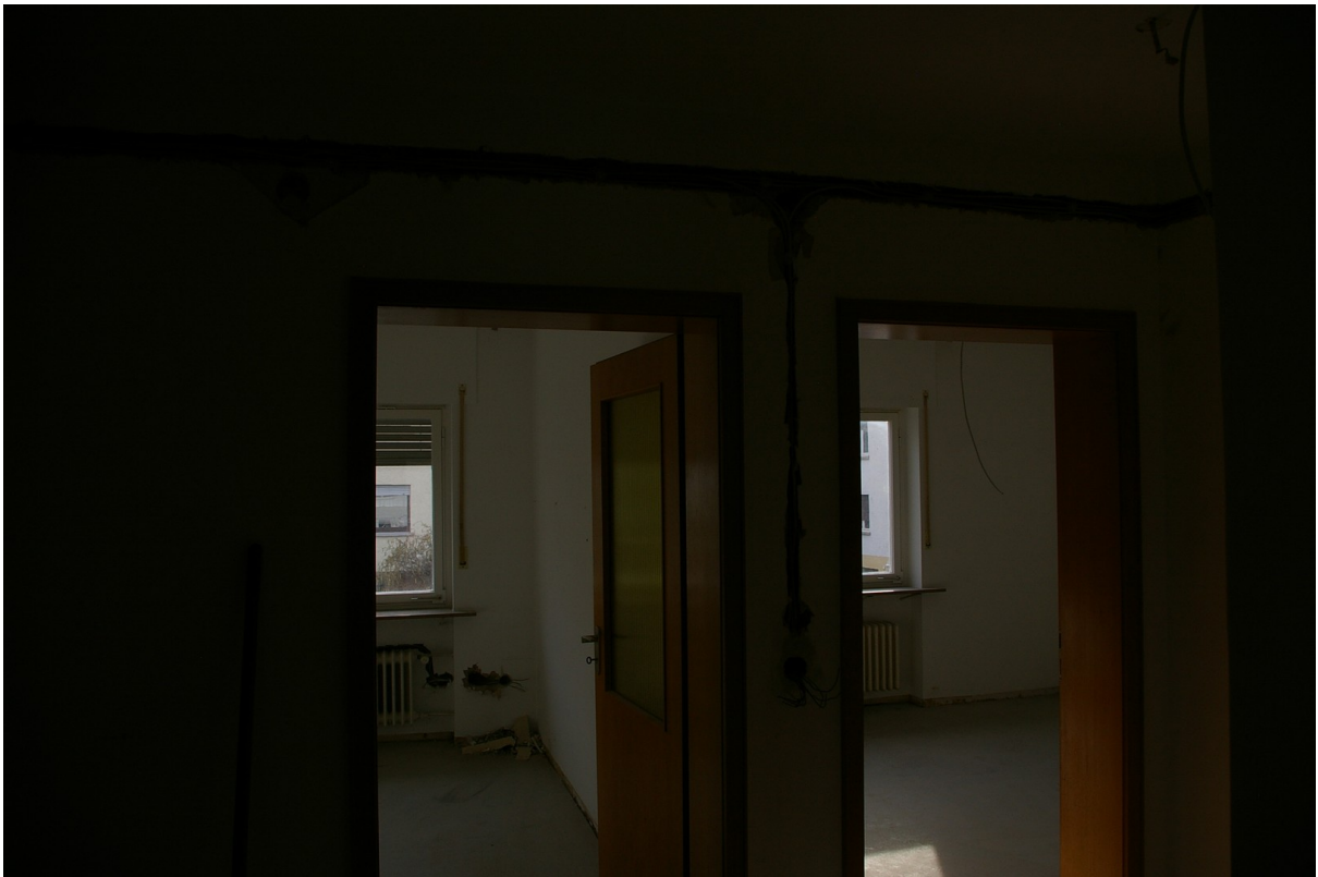
Blick vom Flur
