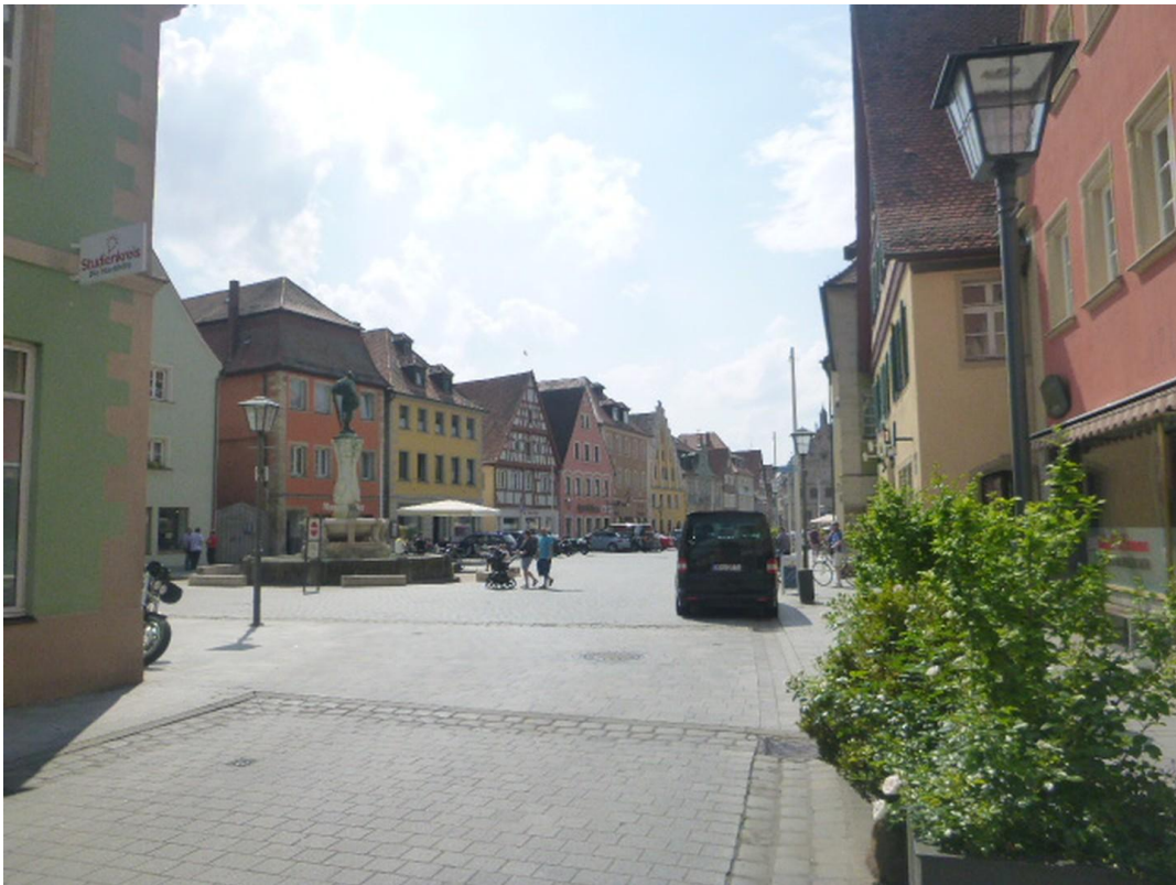
Ansicht von Obertorstr kommend
