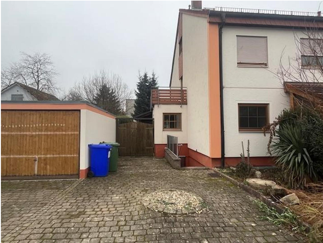
Außenansicht m. neuem Balkon
