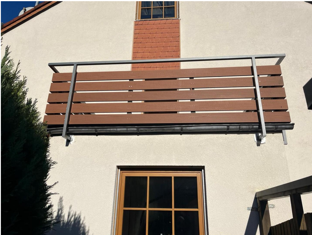
neu modernisierter Balkon
