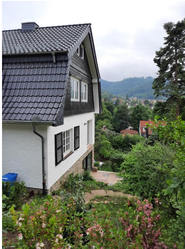
Blick von der Straße
