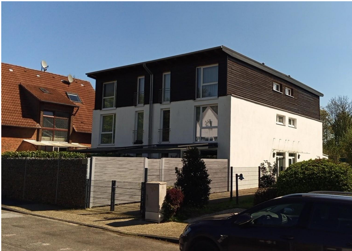
Blick von der Straße
