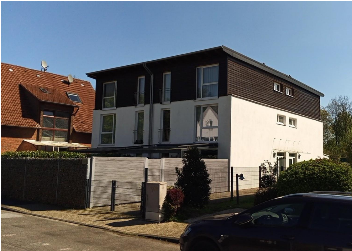
Blick von der Straße
