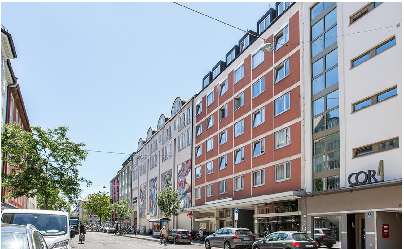
Gebäude Dachgesch Gärtnerplatz
