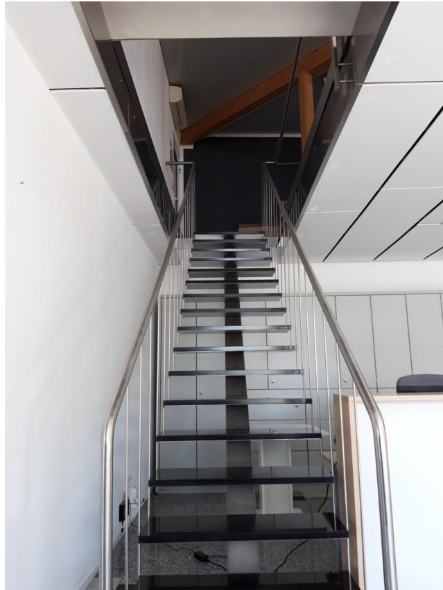
Treppe ins OG
