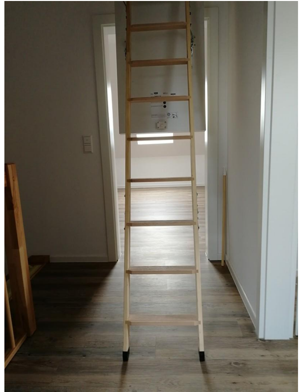
Einschubtreppe zum Spitzboden
