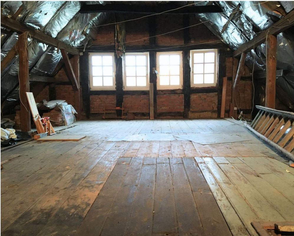
Ausbaureserve im Dachboden
