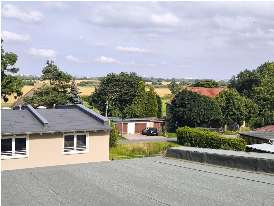
Blick nach Stralsund vom Dach
