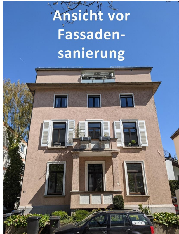
Fassadensanierung in Q2/2025
