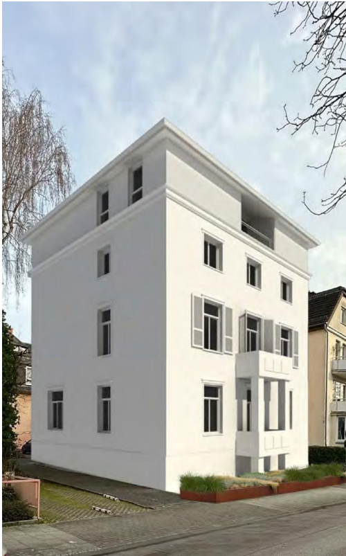
Beispiel der Fassadensanierung
