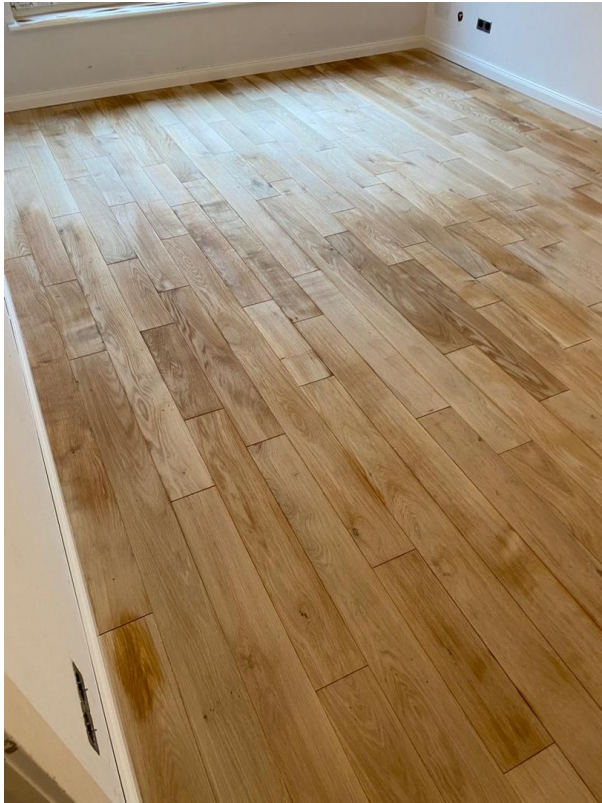
Neu verlegtes Eichenparkett
