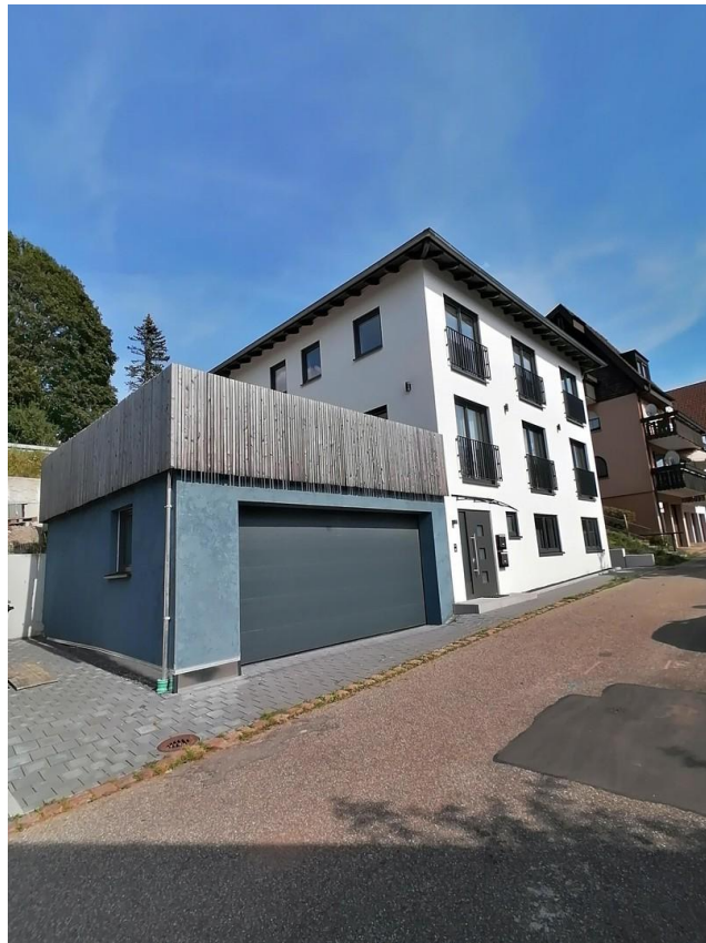
Hausansicht mit Garage
