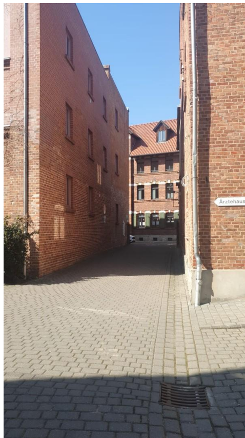
Durchgang Pölkenstrasse - Damm
