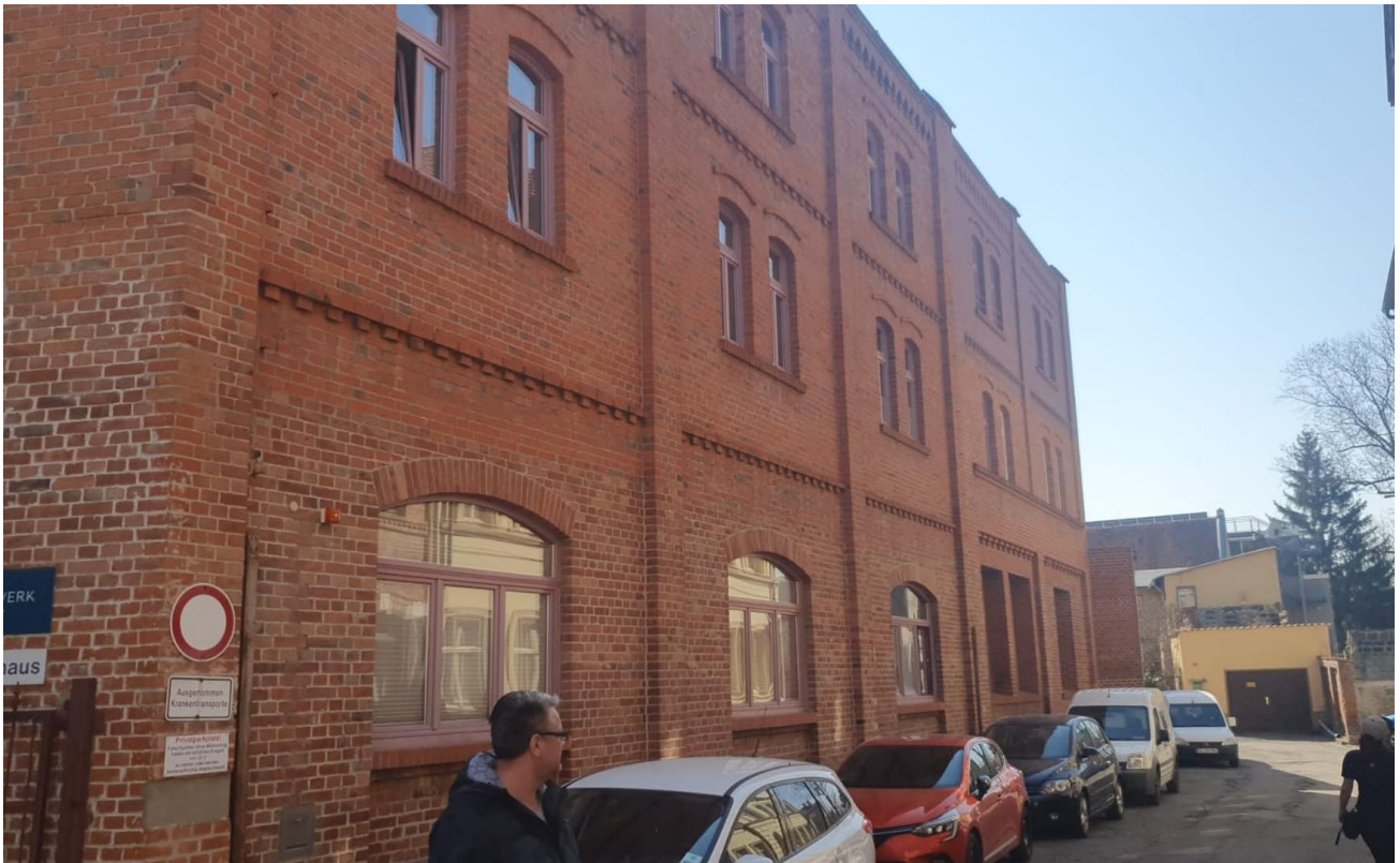
Ansicht Hauptgebäude v. Damm
