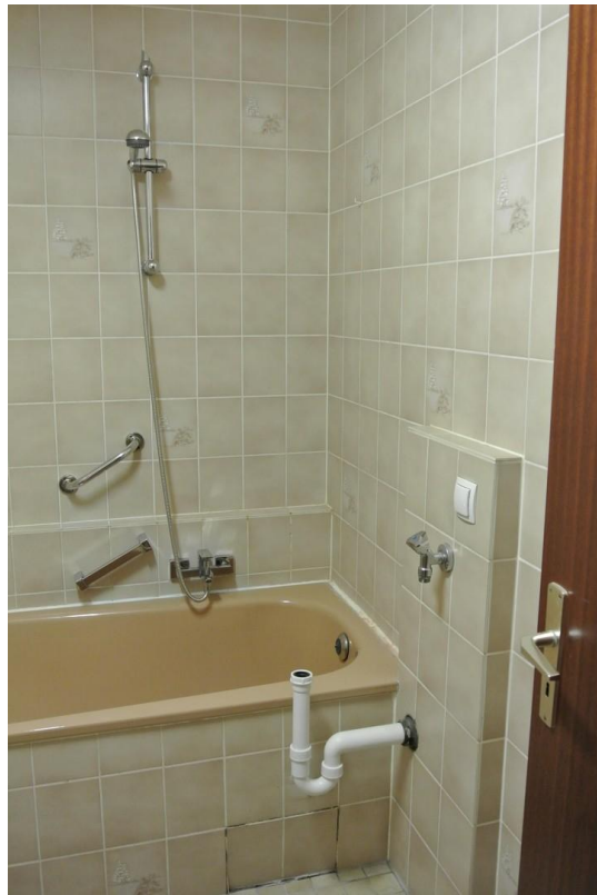
Bad 2, Waschmaschinenanschluß
