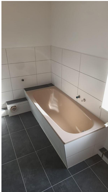
Badezimmer, ohne Armaturen
