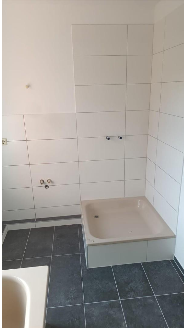
Badezimmer, vor Einbau Dusche
