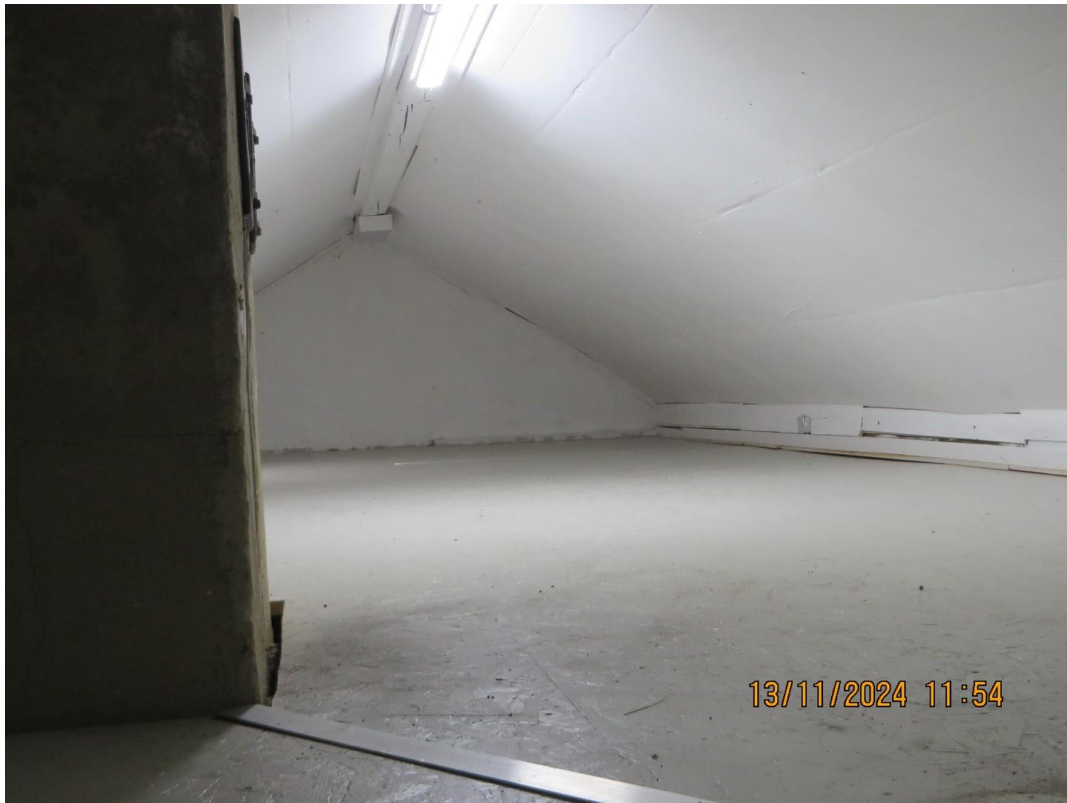
vollisolierter Dachboden 50 qm
