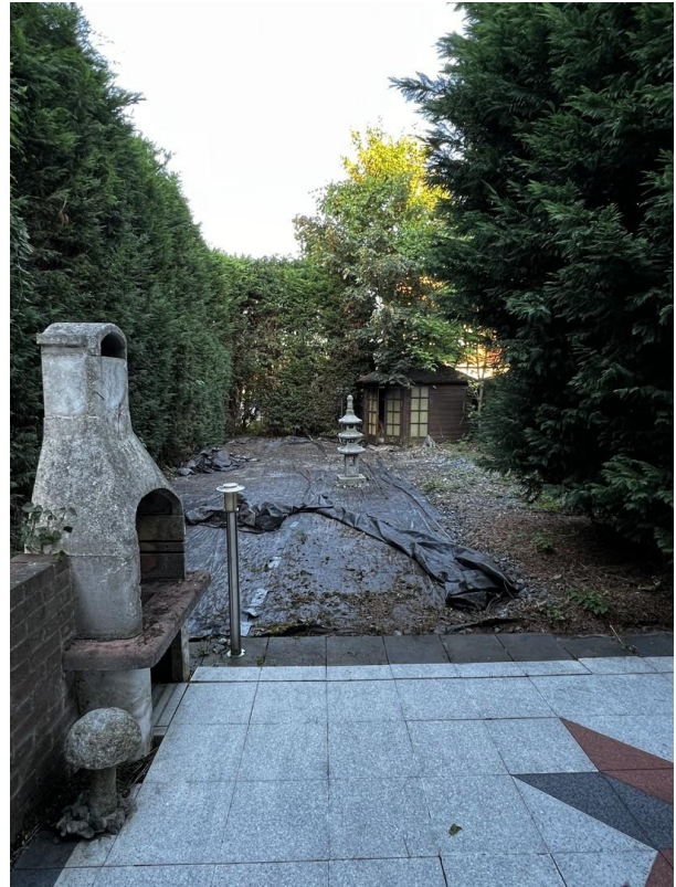
Garten, Rückbau v. Steingarten
