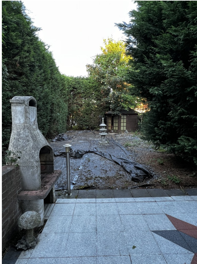
Garten, Rückbau v. Steingarten
