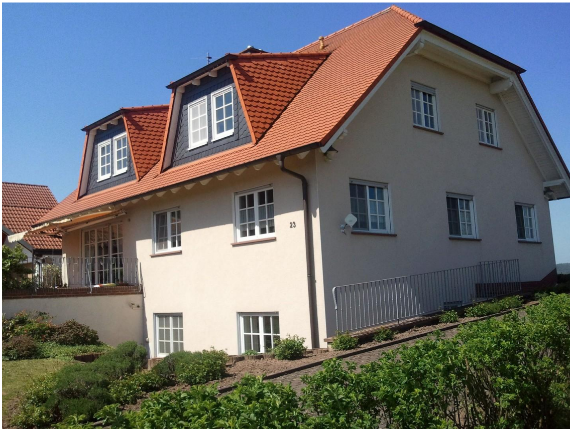
Hausansicht von Südosten
