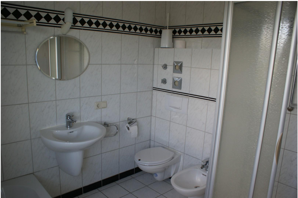
Bad im EG (Wbecken, WC, Bidet)
