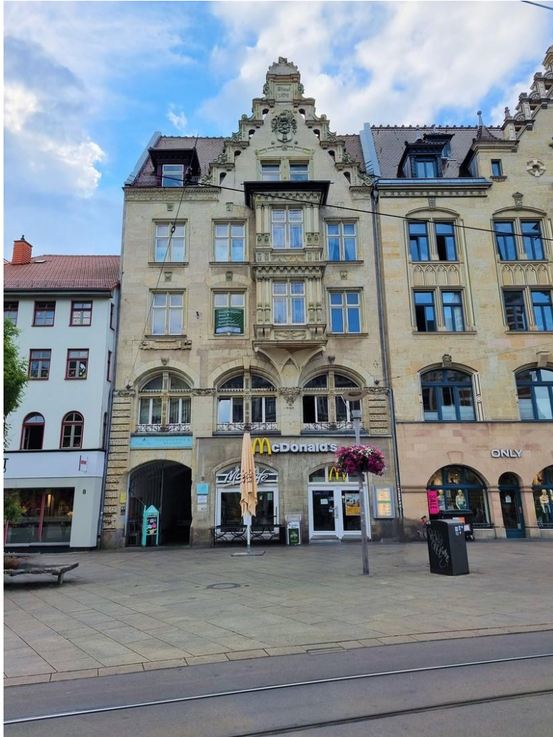
Ansicht von außen
