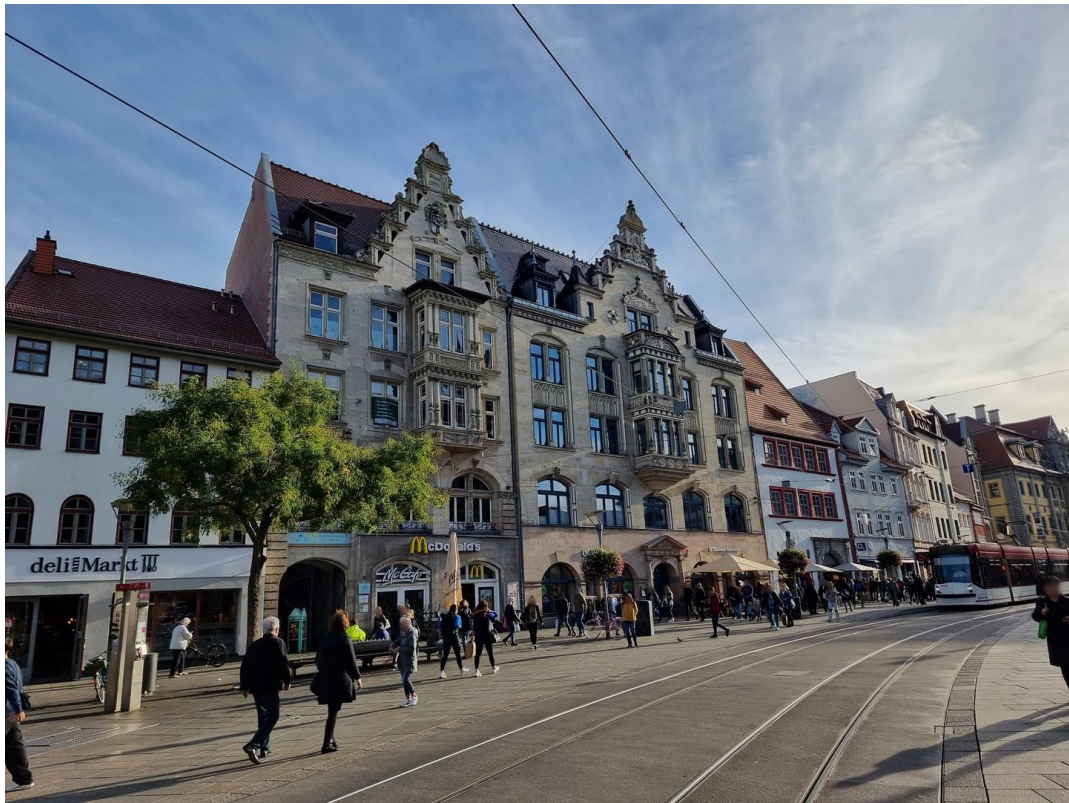
Ansicht von außen
