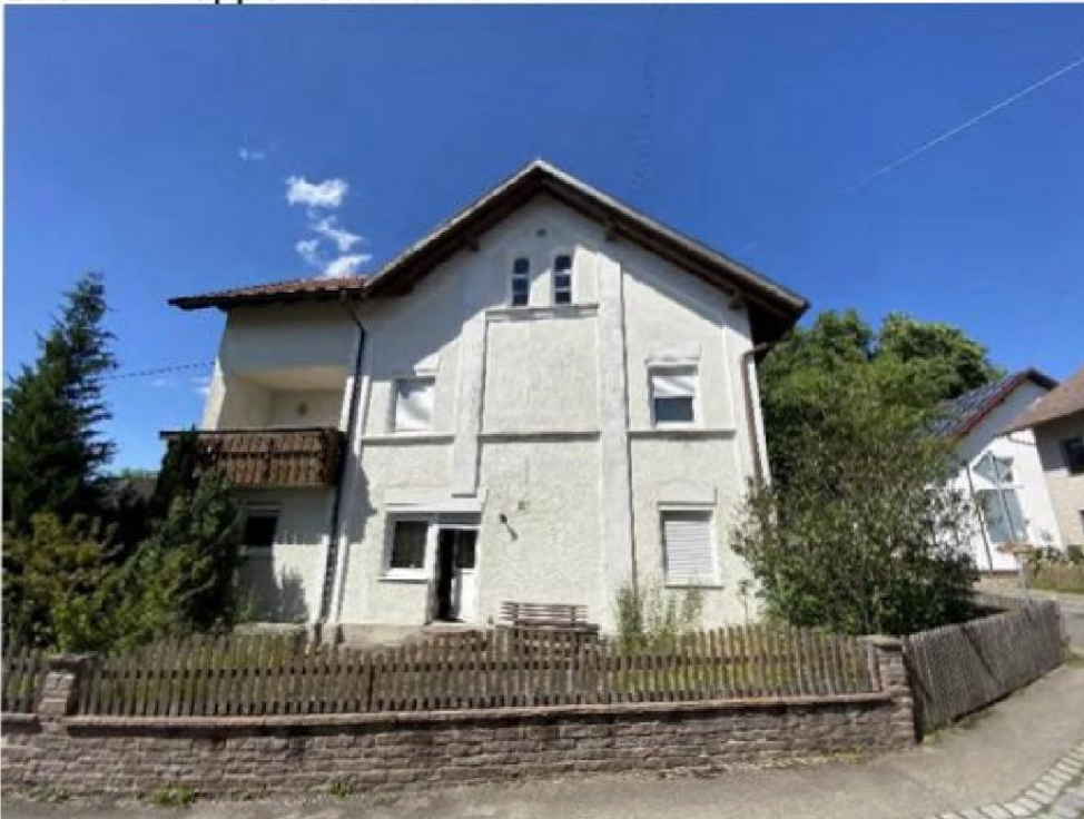
Bild 2 – Doppelhaushälfte von Süden
