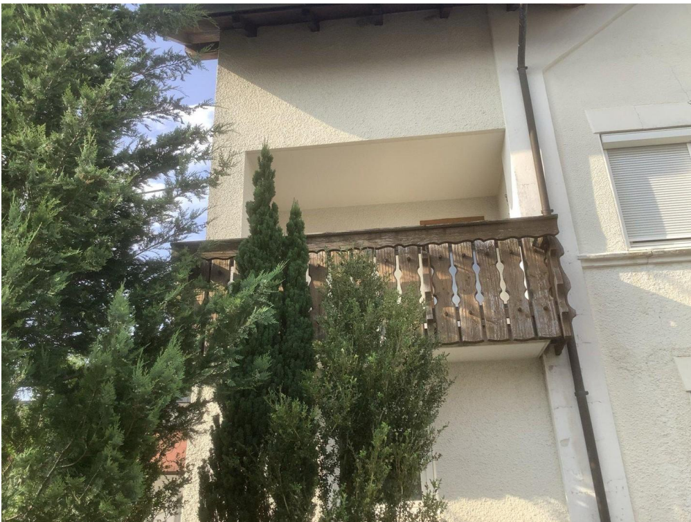
Loggia auf der Südseite
