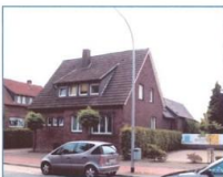
Bild 5: Ansicht „Altbau“, Osttor 62 mit dahinter- liegendem Pultdach des „Neubaus“, Osttor 62a
