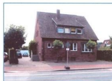
Bild 6: Ansicht „Altbau“, Osttor 62 mit Zufahrt zum „Neubau“ 62a
