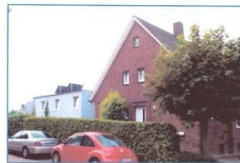
Bild 4: Ansicht der Gebäude „Altbau“, „Neubau“, Osttor 62 und 62a
