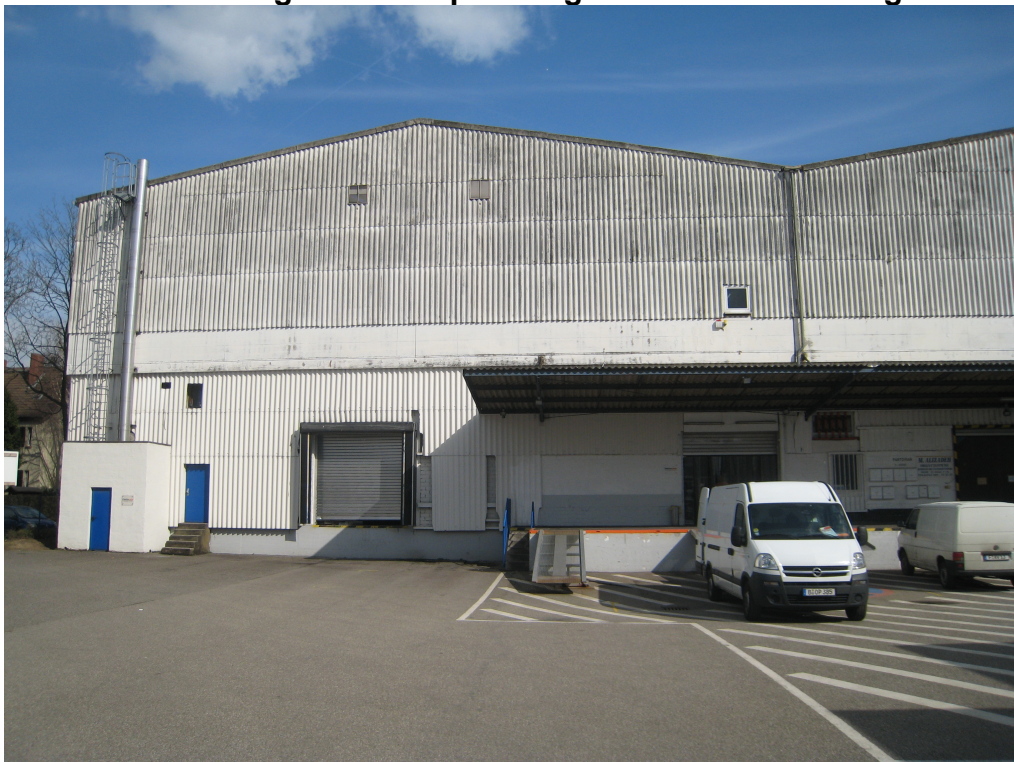
Halle 1 mit vorgelagerter Rampe
