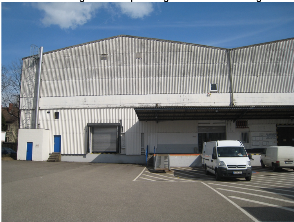
Halle 1 mit vorgelagerter Rampe
