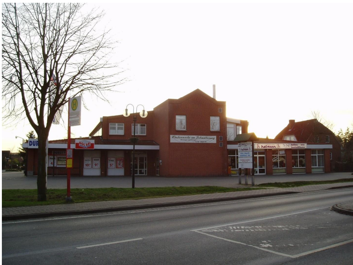
Ansicht von der Elbuferstraße
