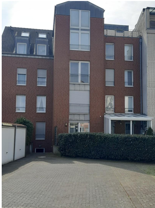
Hausansicht hinten mit Garagen
