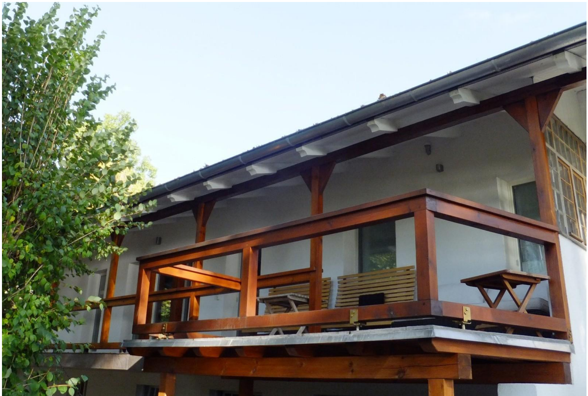
Westterrasse von außen
