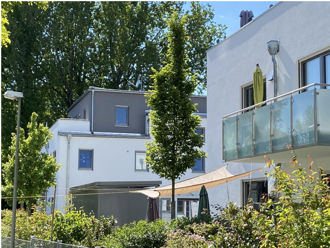
Süden, Balkon der Wohnung
