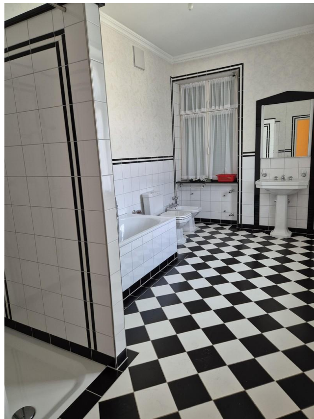
Villa in Schopfheim Bad 1.OG
