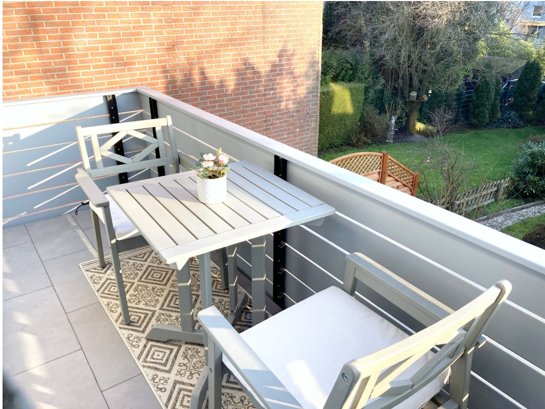
Sanierter Balkon Dachgeschoss
