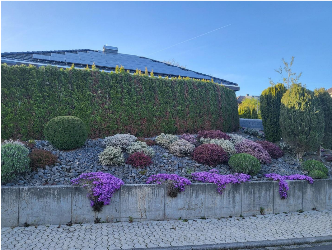
Aussen mit PV Anlage
