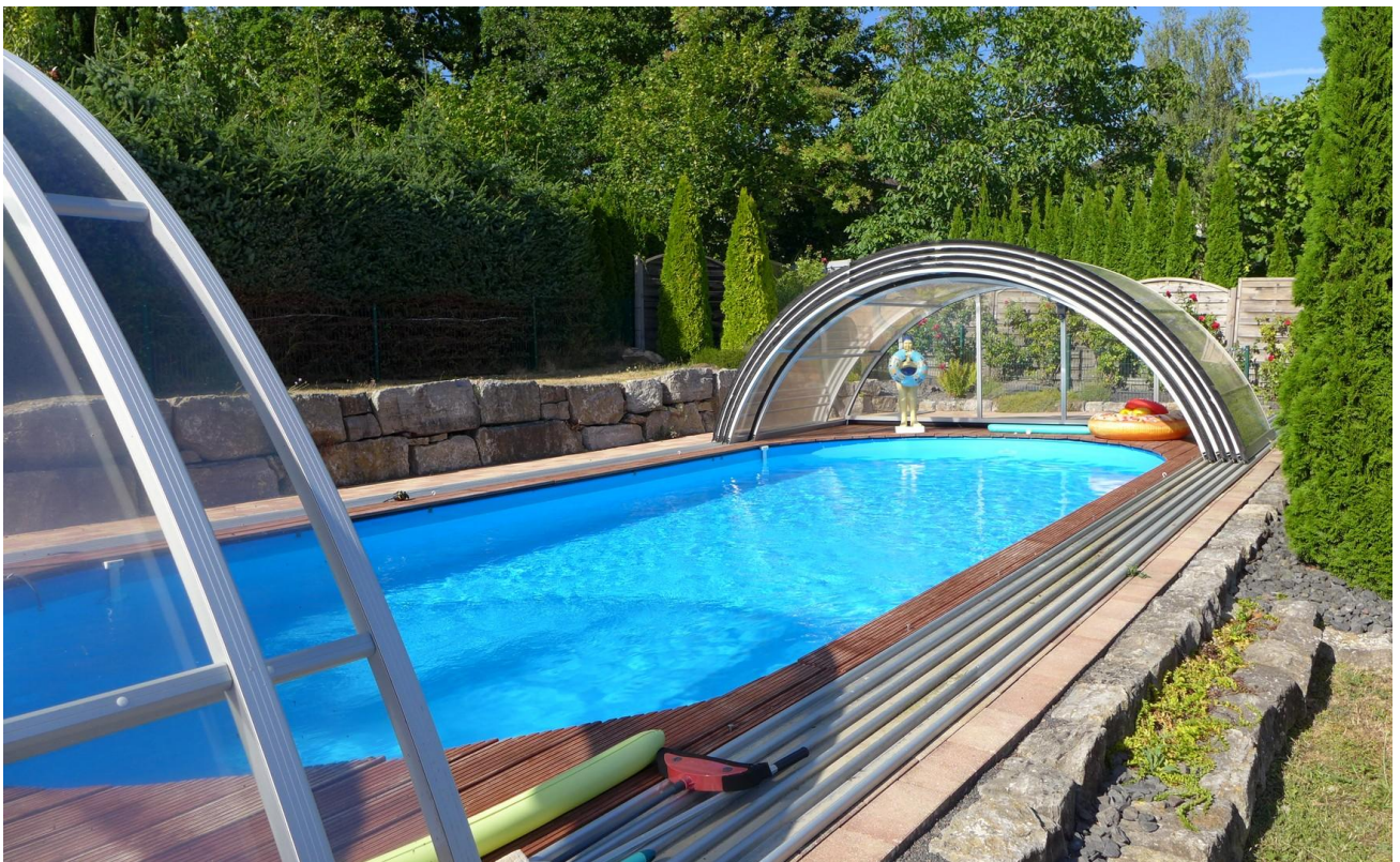
Pool überdacht 10 x 4 m
