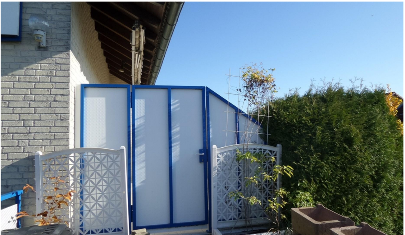
Außenzugang Balkon EG
