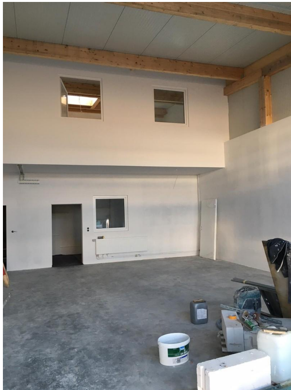
Halle von Innen Bauphase
