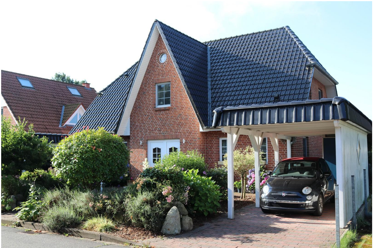
Vorderseite mit einem Carport
