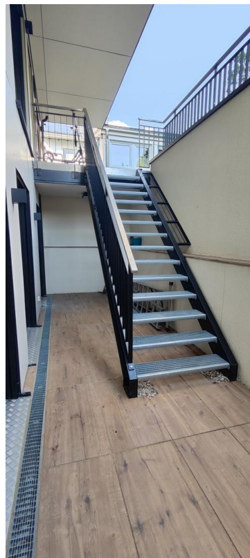
Freitreppe Souterrain zum EG
