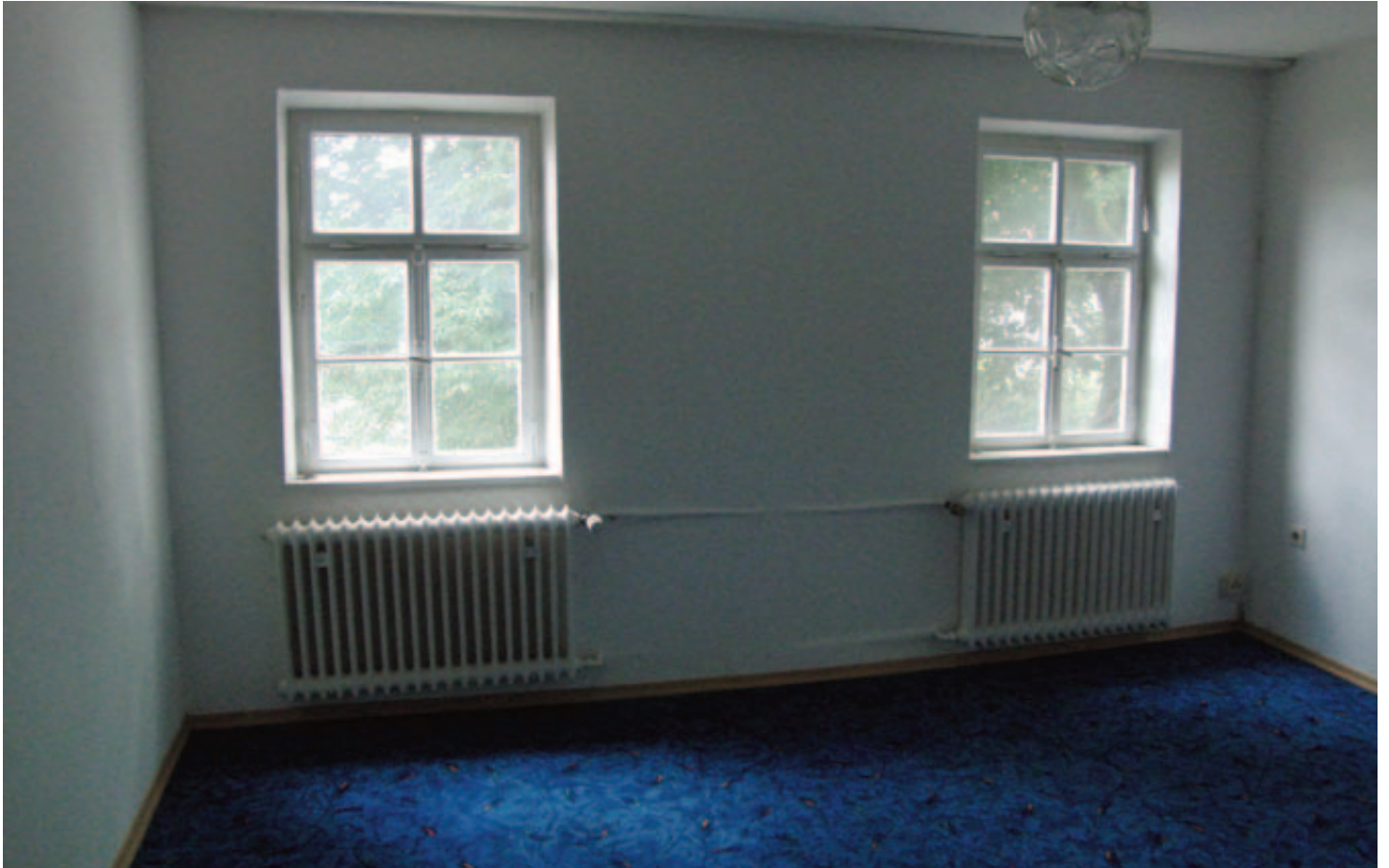
Raum 2 - mit den Anschlüssen für zusätzlichen Waschbecken
