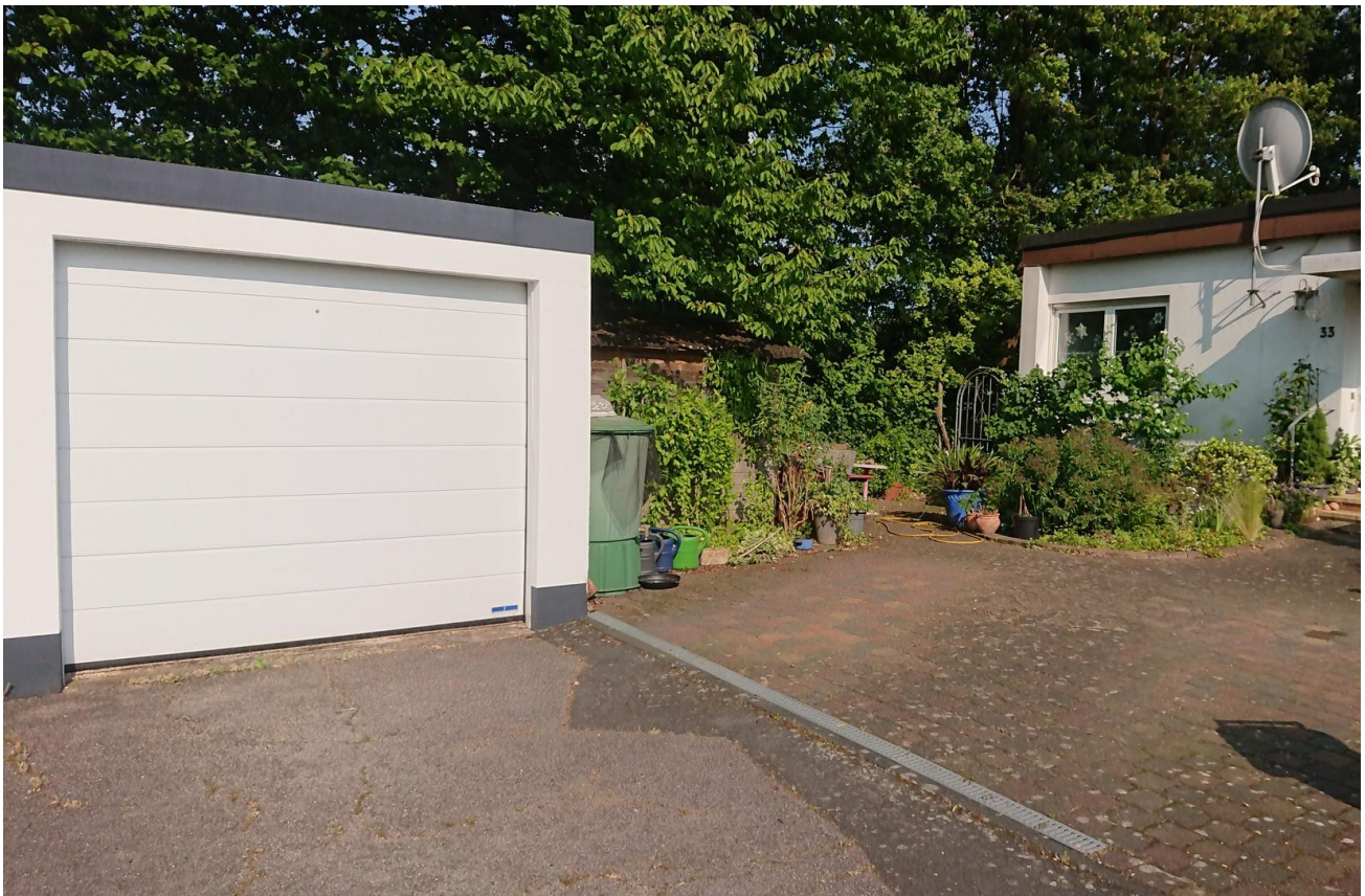
Ansicht Vorderseite mit Garage
