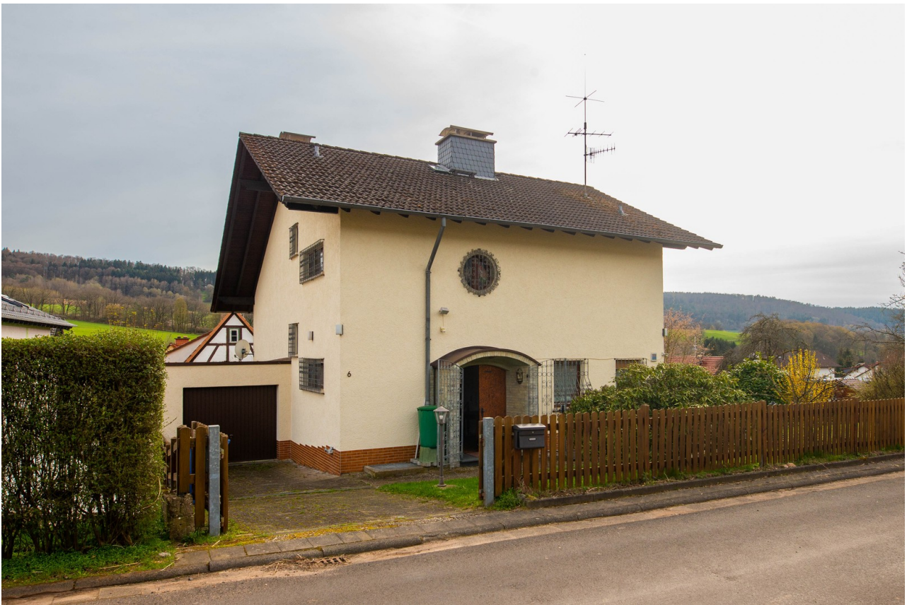
Ansicht Eingang Straßenseite
