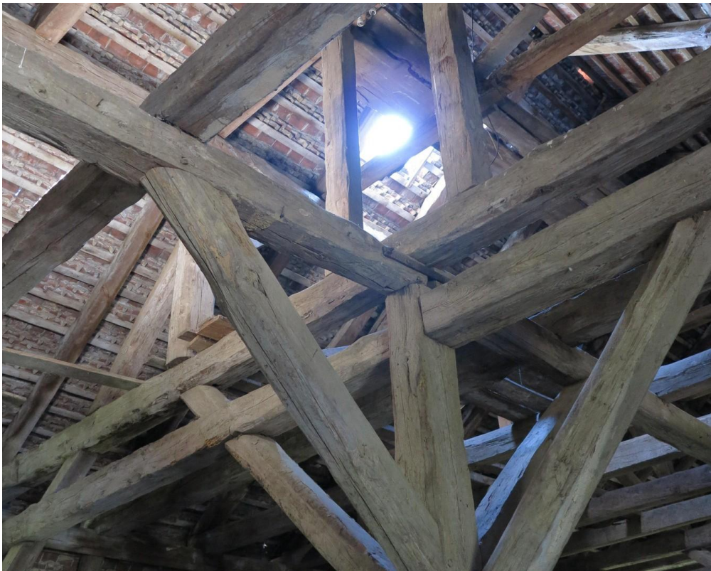
Ständerwerk DG & Spitzboden
