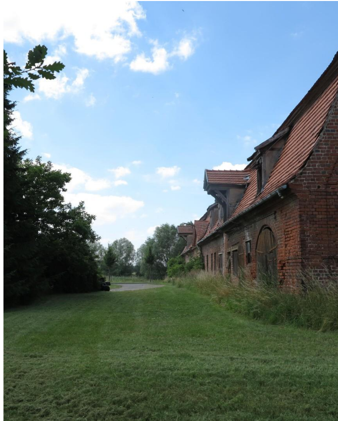
unter d.Rasen liegt d.Pflaster
