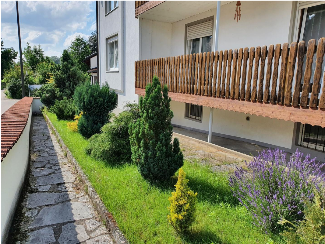
Ansicht von Straße 2 Balkone
