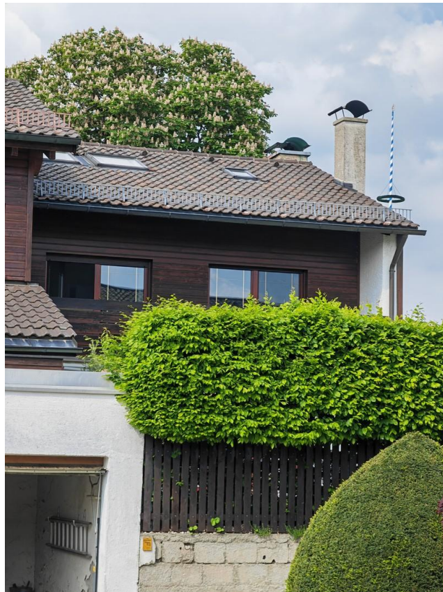
Ansicht aus Süden
